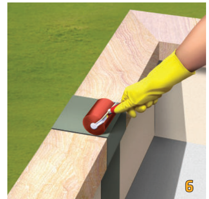
Dùng rulo cao su lăn ép chặt Multiseal vào bề mặt cần thi công.
