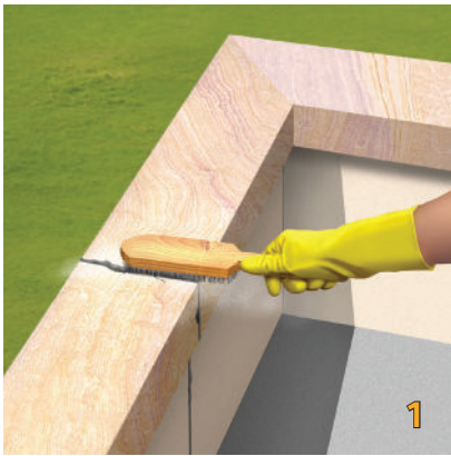
Vệ sinh sạch sẽ bề mặt.
