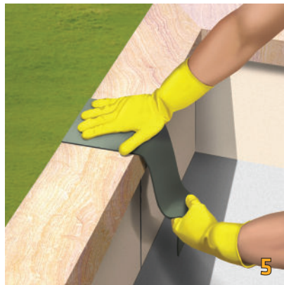
Dán Multiseal lên bề mặt thi công.
