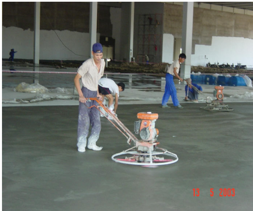
Hình 3. Thi công bột tăng cứng mặt sàn
